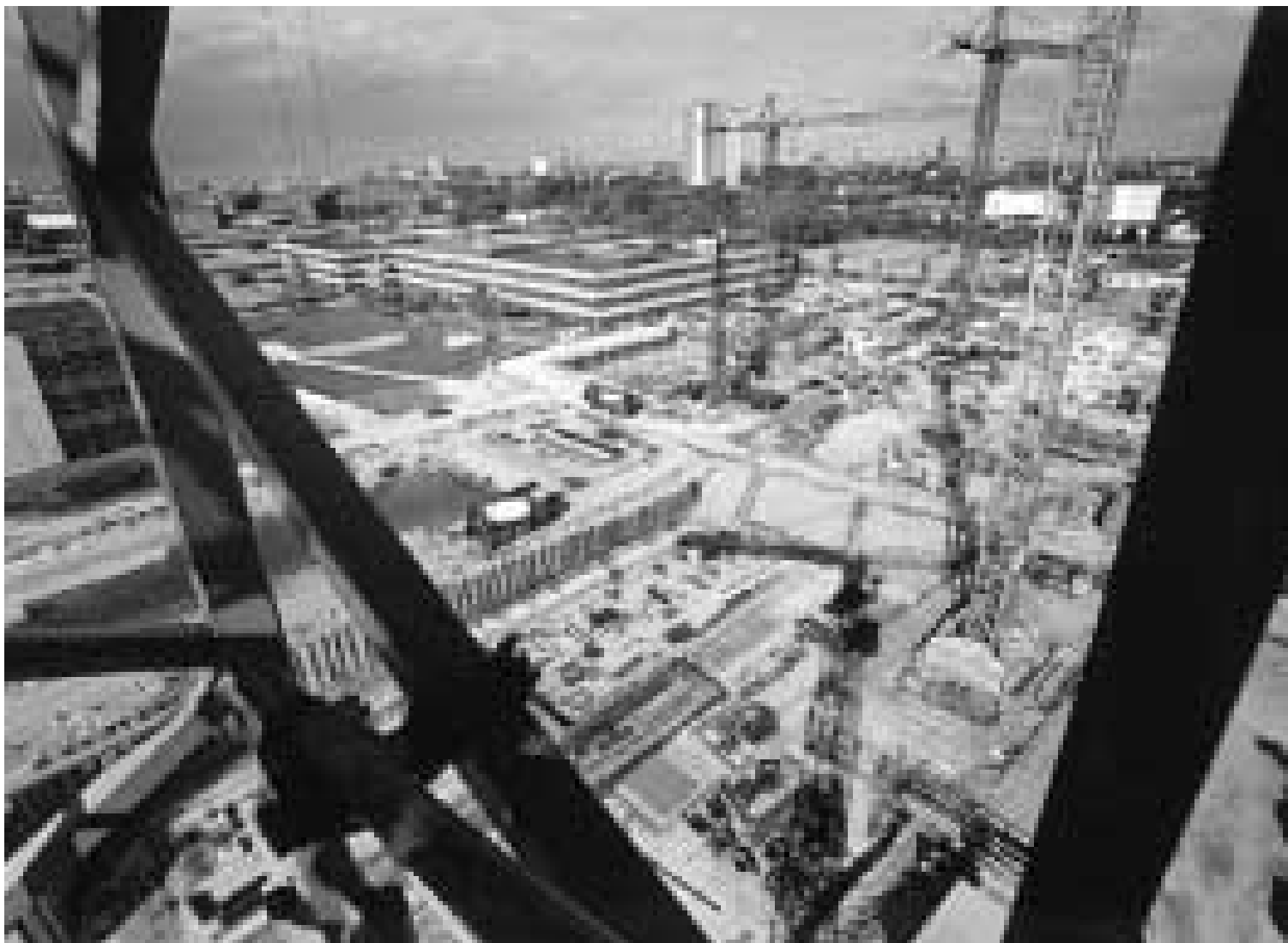
Sådan så nybyggeriet i Ørestaden ud i midten af september måned 2000. Det flade byggeri i baggrunden er det gamle KU-Amager, hvis nogle er i tvivl.
