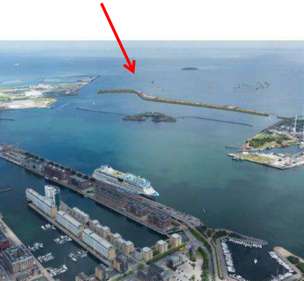
Sikring ved Nordhavn/Trekroner
